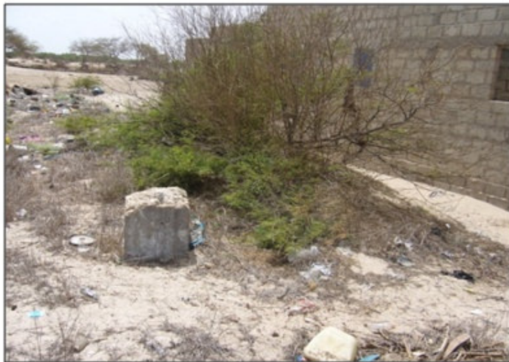
Photo 2. Un poteau, témoin d'installations en ruines (SY B., 2009)
